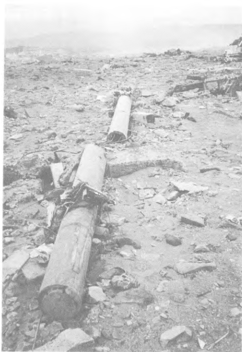
写真5 津波で折損した電柱
