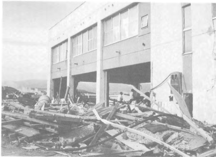
写真4 津波に耐えた奥尻漁業協同組合の建物 —青苗地区
