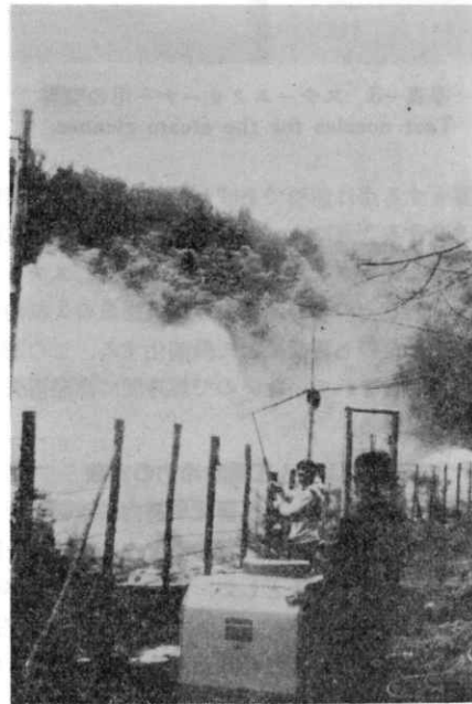
写真—2 スチームクリーナーと噴霧状況 Spraying with a steam cleaner.
