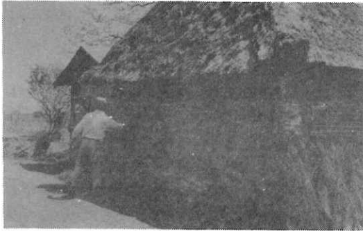
写真-2 惣領分地区の地盤沈下に伴う家屋のひび入り
