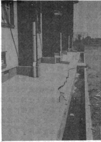
写真-1 不等沈下に伴う新築江北中学校講堂のき裂
