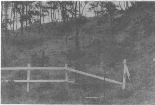
写真-27 牧場内の緩傾斜地には地表侵食、崩壊が見られない。
