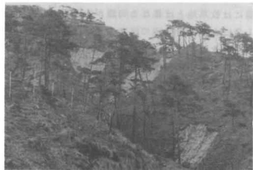
写真-26 牧場内の急斜部に発生した崩壊
