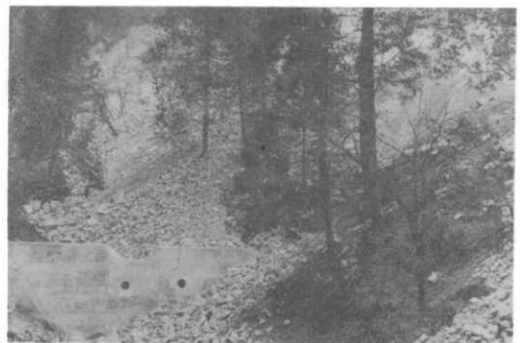
写真-29 林道の切取り土砂
