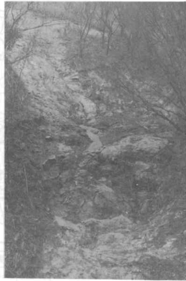
写真-6 広葉樹の疎林に発生した大きな崩壊
