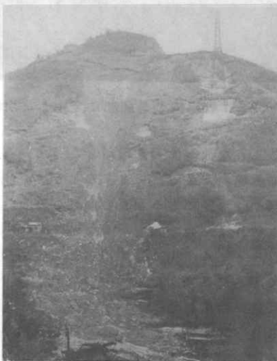
写真-28 ゴルフ場に発生した大崩壊
