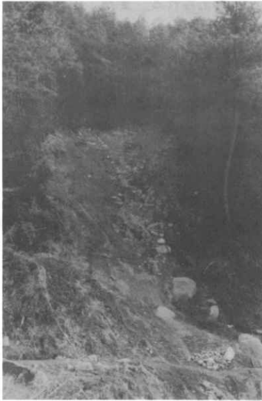
写真-5 林地の崩壊 (沢頭の傾斜変換部, 下は水田)
