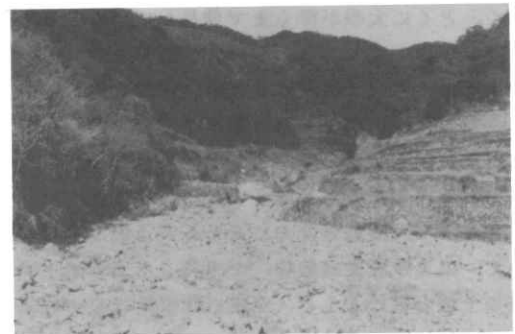
写真-19 荒廃溪流(下流部)
