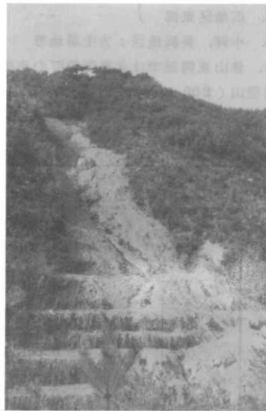
写真-7 水田の被害 水田は沢の中央部まで造成されていた。
