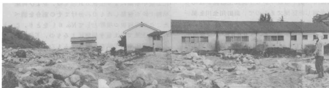
写真—2 下流部の被害状況（広島県土木事務所撮影）
