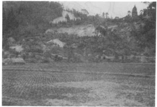
写真8 すべり性崩壊。鶯田付近の段丘面。(第2回地震直後撮影)
