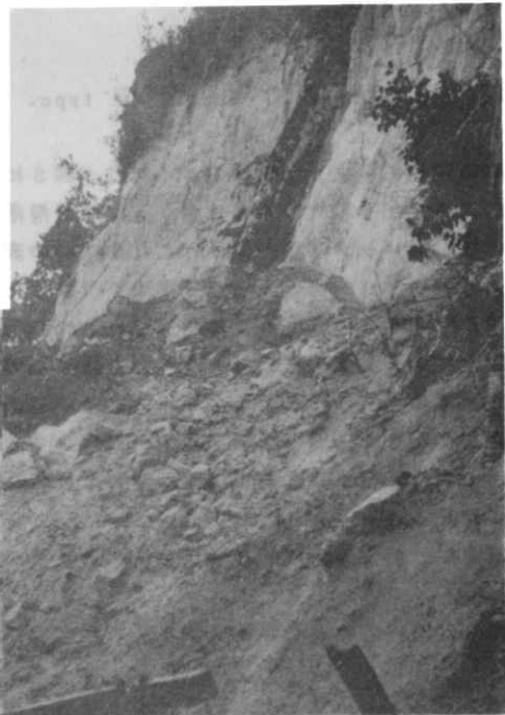
写真5 ブロック型崩壊 (第2回地震直後撮影)
