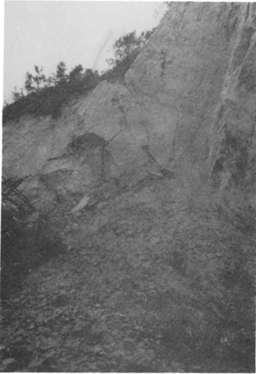
写真6 ブロック型崩壊。タテ割れ沿いに崩落している。(第2回地震直後撮影)
