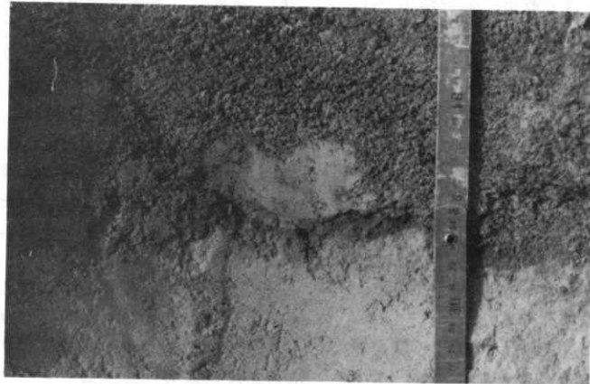
写真20 第1モデル斜面上部。シラス露出地の粘土化層。
