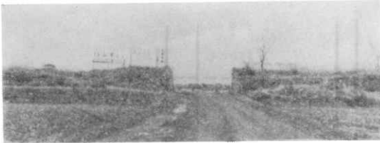
写真 1-17 第二線海岸堤防
