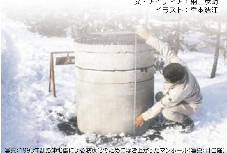
写真：1993年釧路沖地震による液状化のために浮き上がったマンホール(写真：井口隆)
