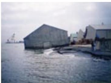
液状化により海側に流動化した護岸と傾いた建物（1995年兵庫県南部地震、神戸港）（提供：若松加寿江）
